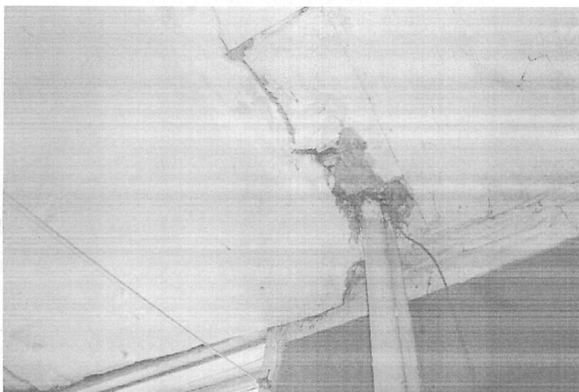
Фото 21. Фрагмент интерьера. Разрушение перекрытий.
